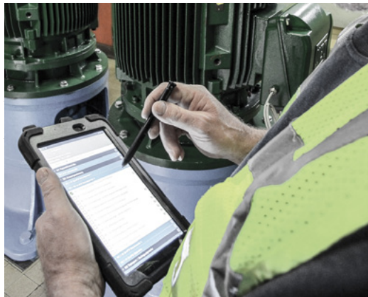
Mitarbeiter der Wasserversorgung kontrollieren deren Anlagen regelmässig.
