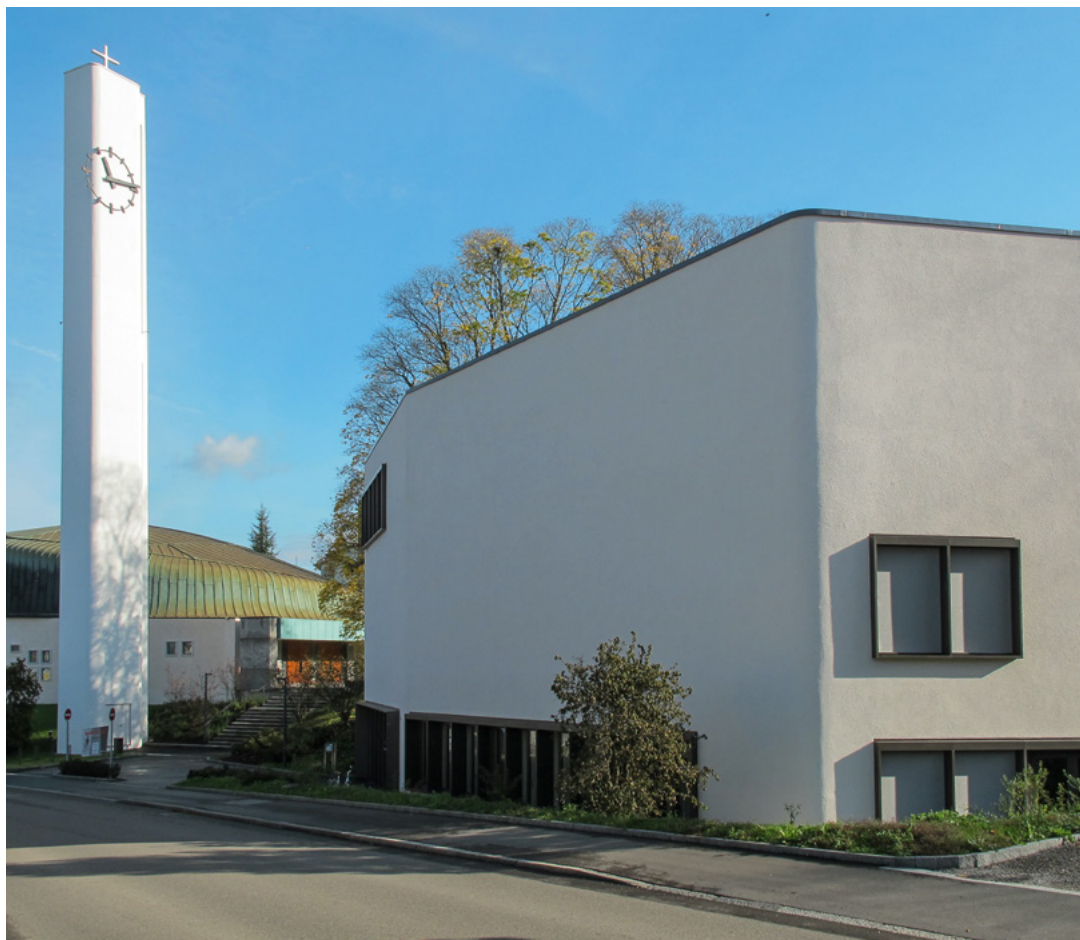
Die St. Josef Kirche mit dem neuen Pfarreizentrum (rechts).
