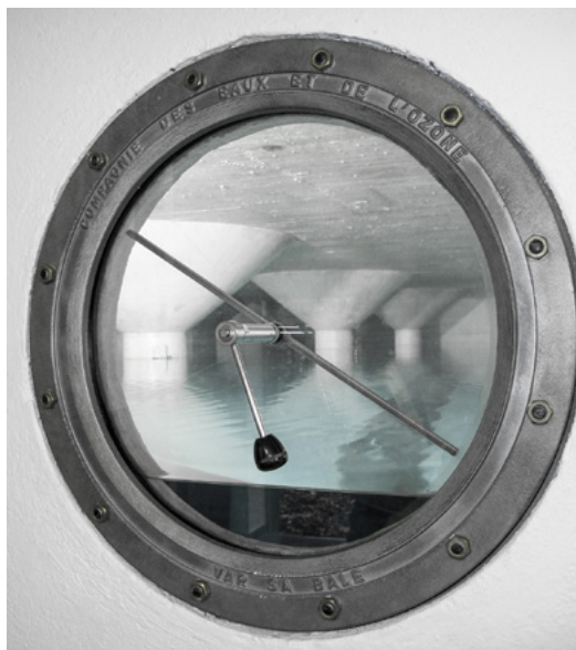
Blick ins Reservoir Bröggen.
